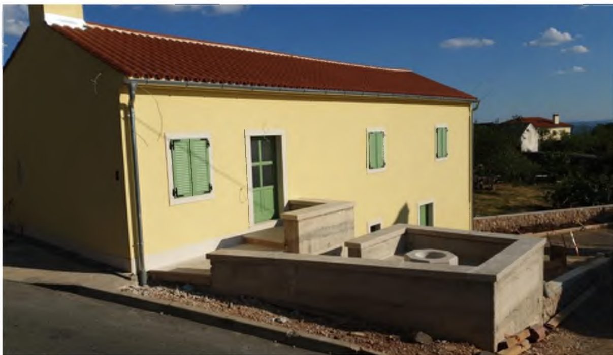
Obnovljena Marohnićeva kuća, fotografirao Radovan Tadej 3. kolovoza 2022.
